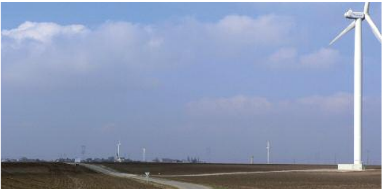
Fig. 149 : Impact d'une éolienne au premier plan d'un paysage.
